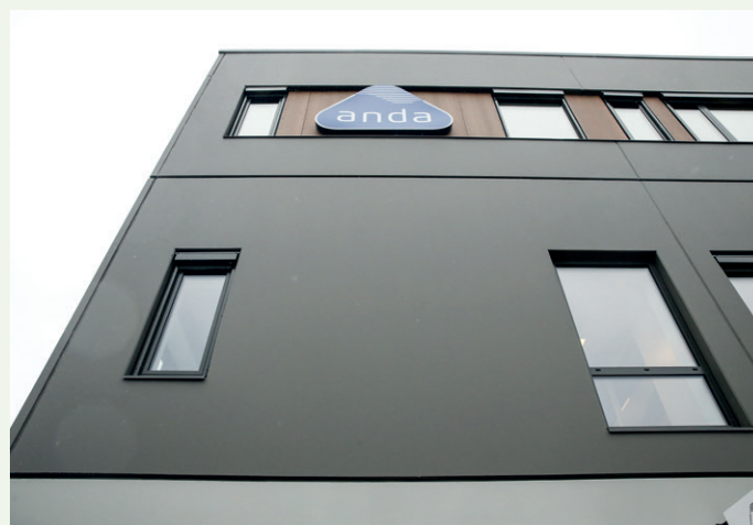
På denne delen av fasaden er det malte betongelementer i kombinasjon med innslag av Steni-facadeplater, og aluminiumsvinduer fra Straumsheim Glass og Fasade.
